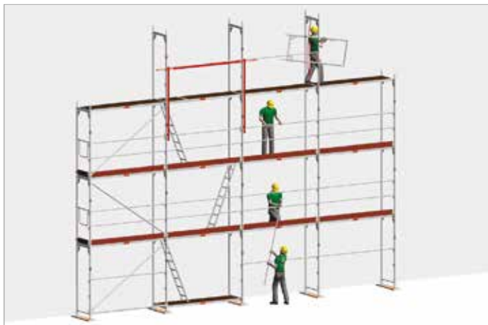
Bild 32: Montage av ställning med hjälp av PFU
