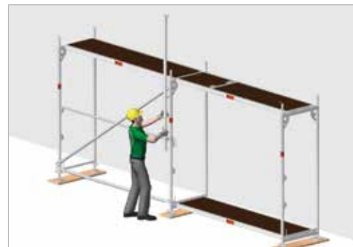
Bild 71: Montering av den första MSG stolpen
