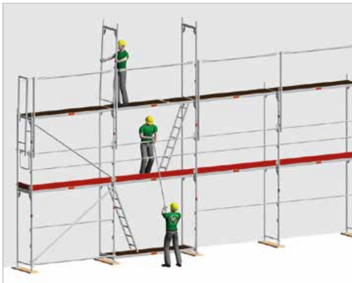
Bild 3: Exempel på vertikal transport av byggnadsdelkomponenter manuellt
