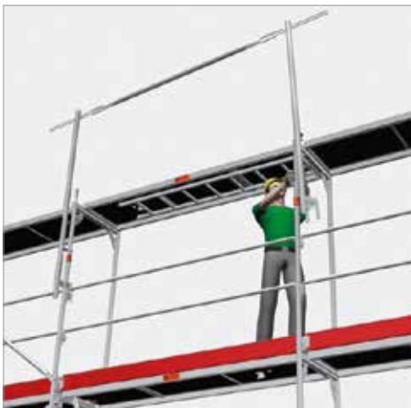
Bild 30: Montage av MSG i ett ställningsfack med steg
