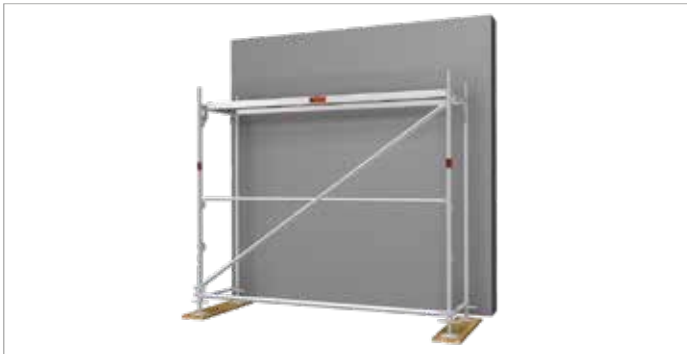
Bild 17: Färdigt montage av första ställningsfacket
