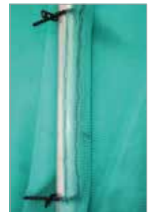
bild 70: Fastsättning av ställningsduk på ställningen
